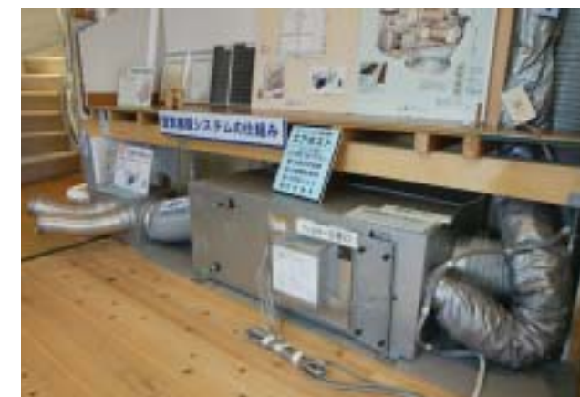
住宅構造体の内側と外側に空気の通り道を設け、独自の空気循環を実現するDK・工法
