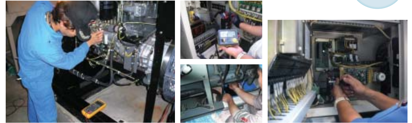
現場での保守・点検・修理・整備作業
